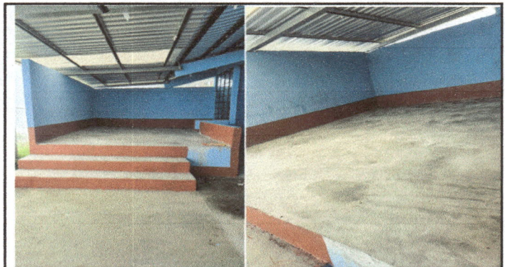
Foto 4: Se observa el trabajo de la rehabilitacion de la pared del escenario con piso de torta de concreto.
