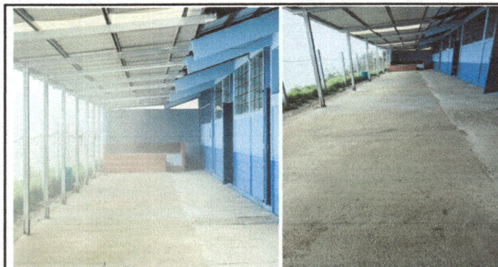
Foto 3: Se observa la finalización de trabajo de la rehabilitación de torta de concreto en el pasillo de los modulos.
